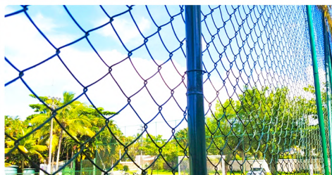
Recuperação de estruturas dos alambrados do campo de futebol (sintético)
