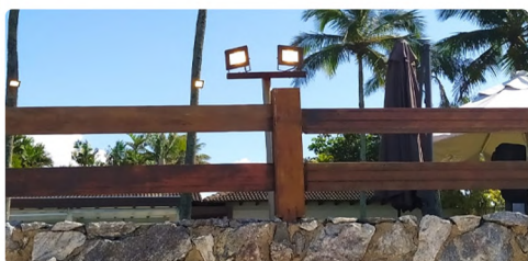
Instalação de refletores na Faixa de Areia
