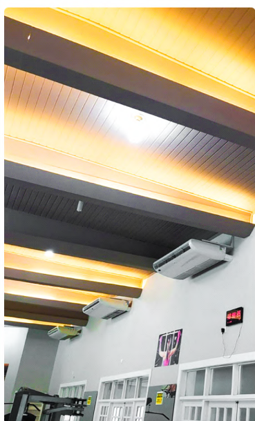
Novos aparelhos de ar condicionado
