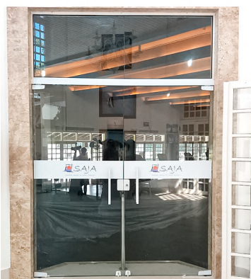
Instalação de porta no Hall Social de Academia
