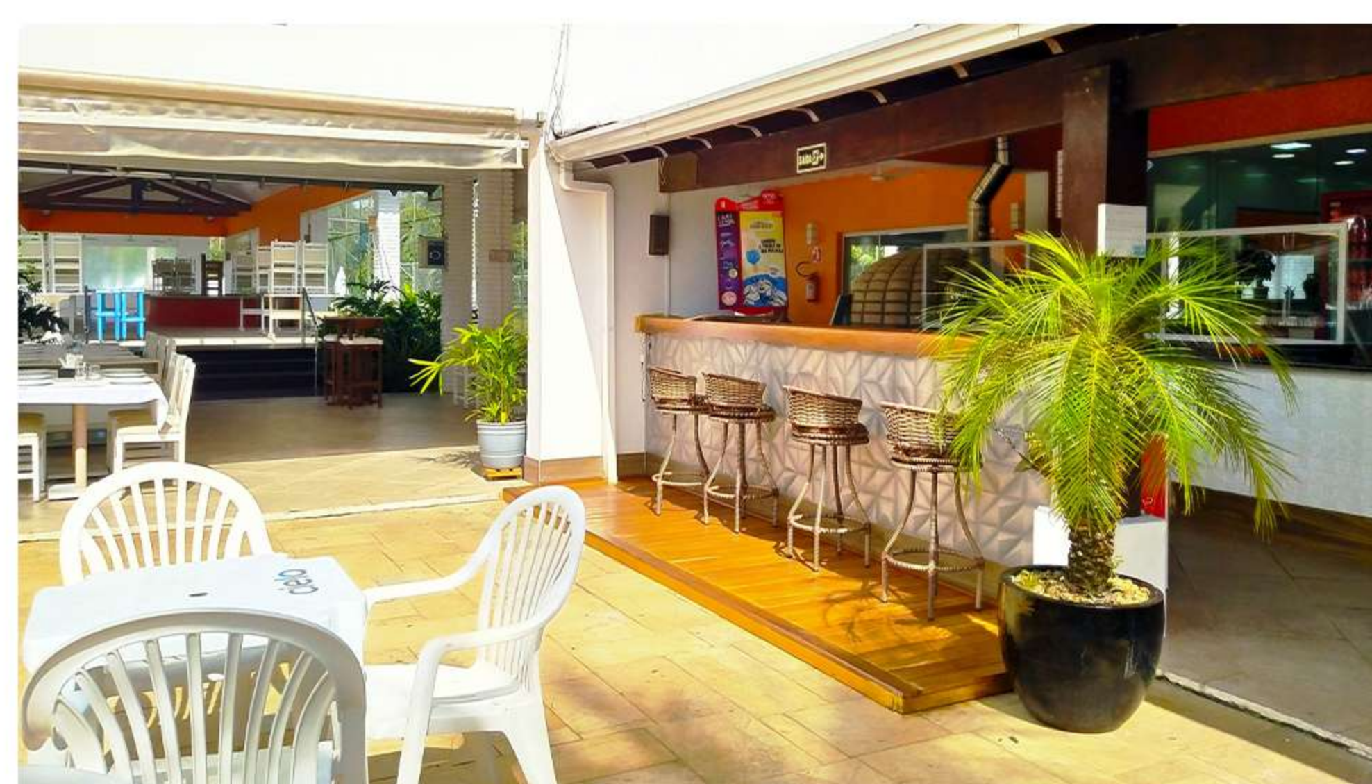
- Reparos na área externa do restaurante Brisa do Mar
