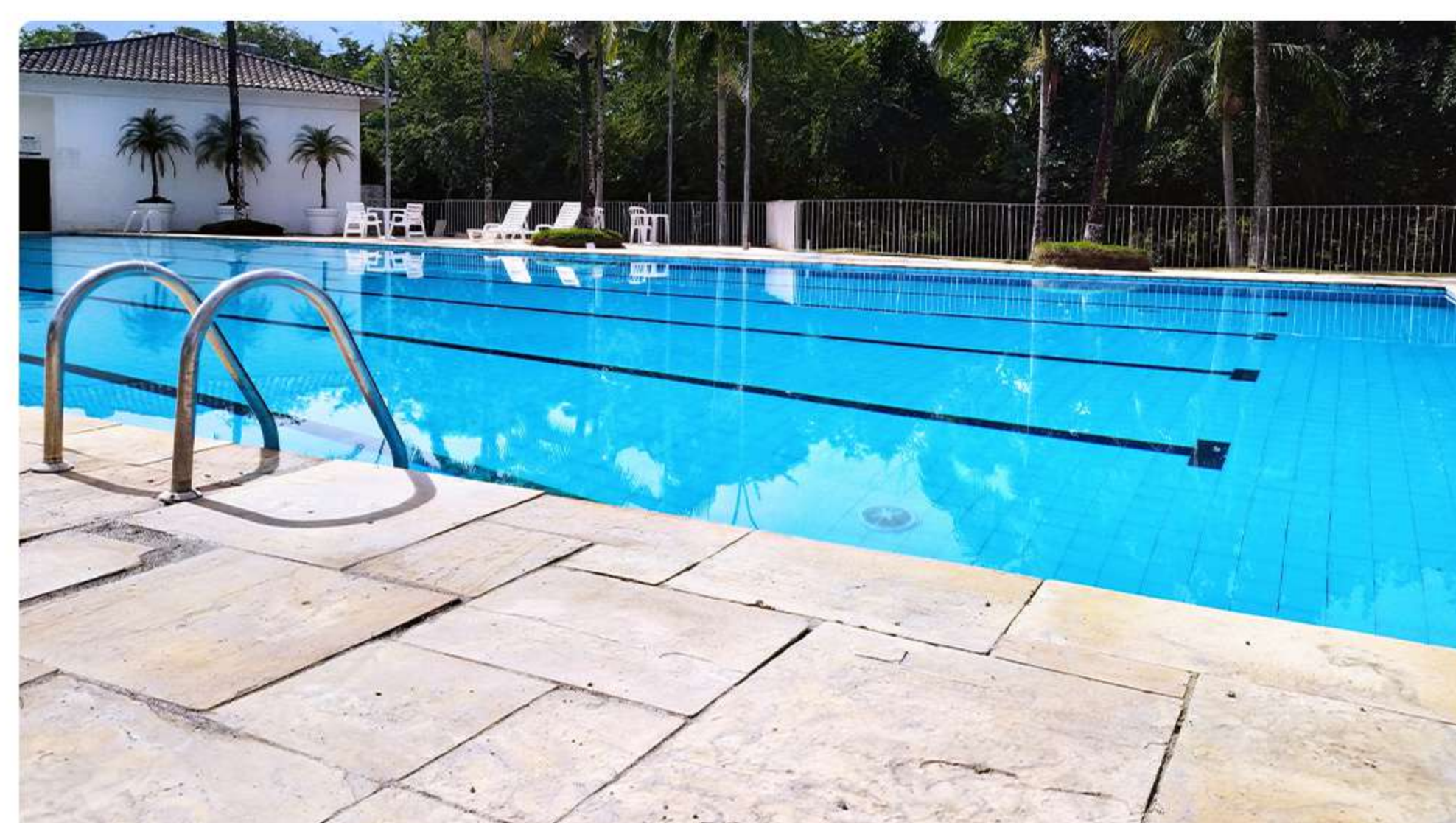
- Reparo de vazamentos na piscina olímpica
