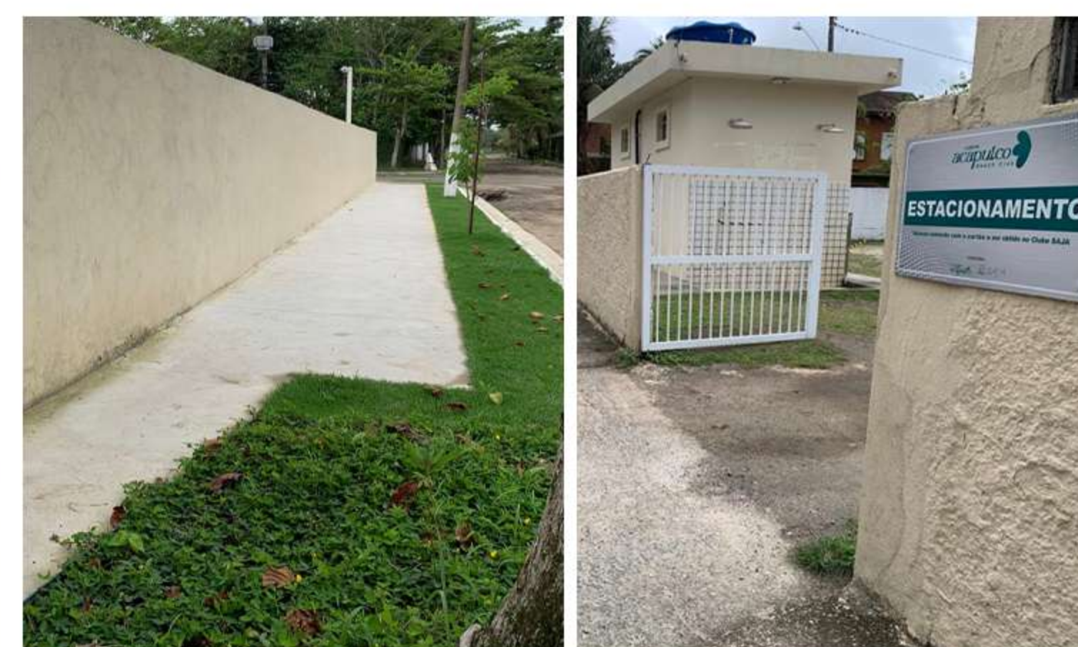
Manutenção de calçada e revitalização do estacionamento
