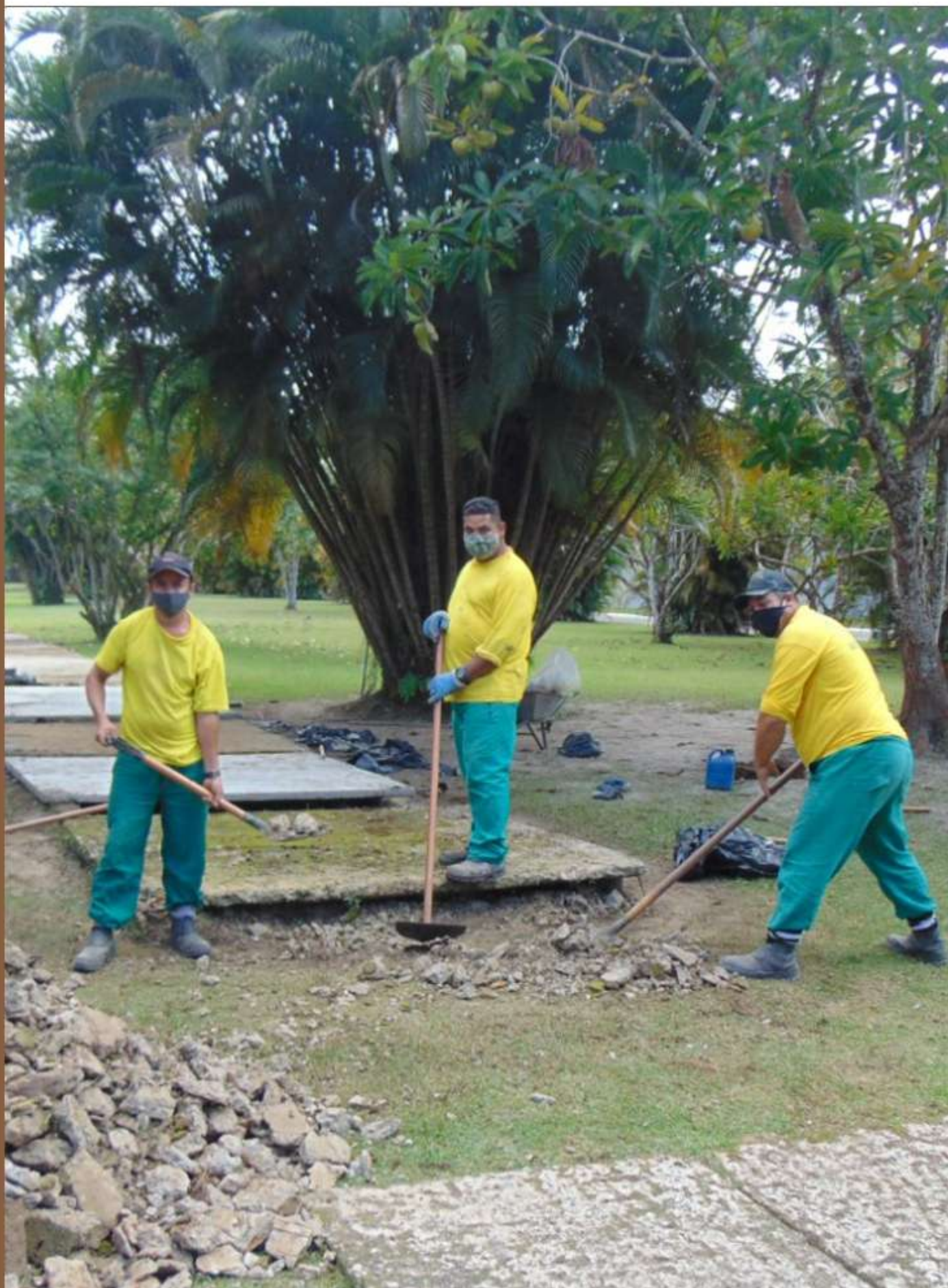
Manutenção de galerias
