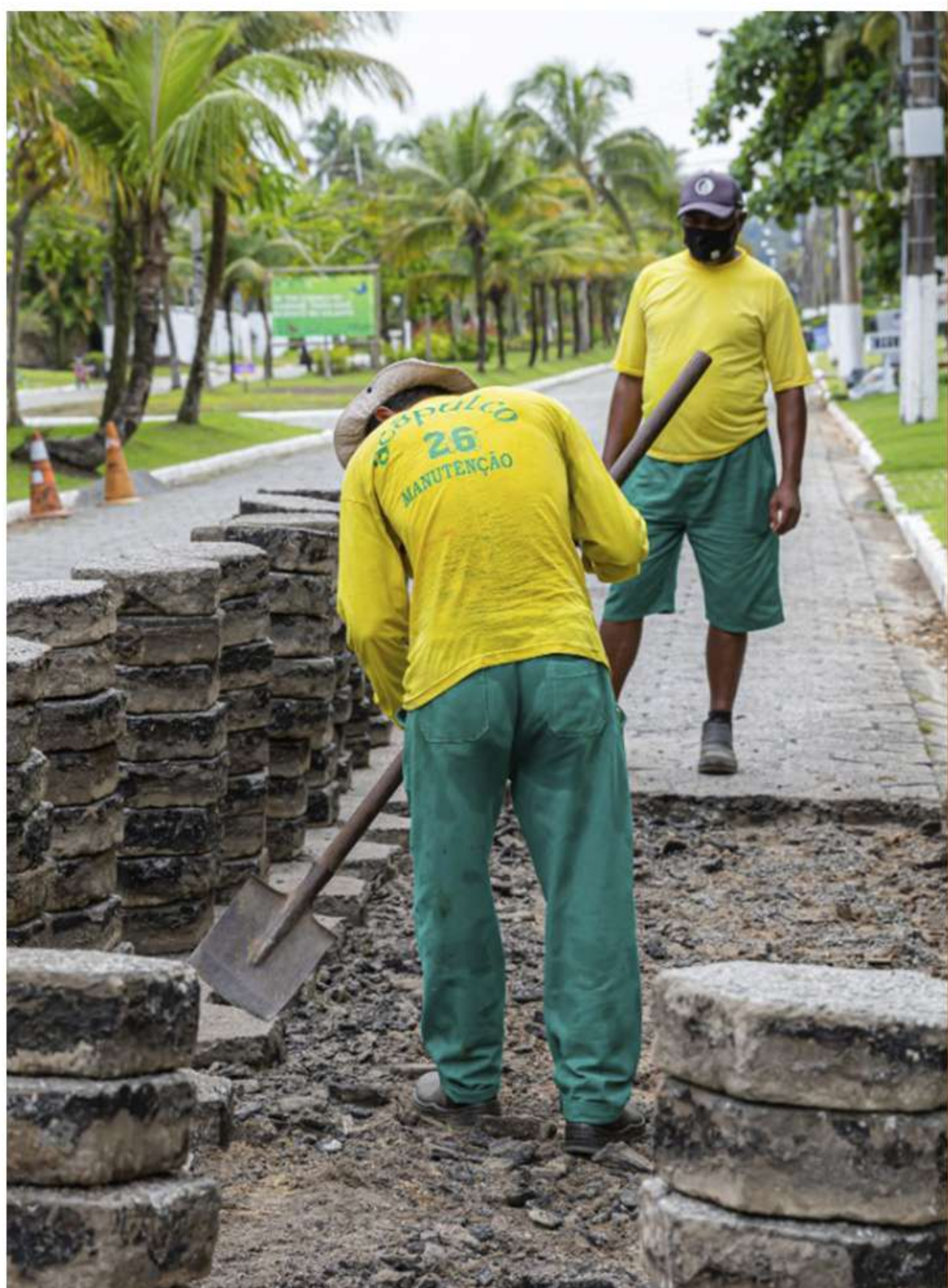
Manutenção de calçamento nas vias
