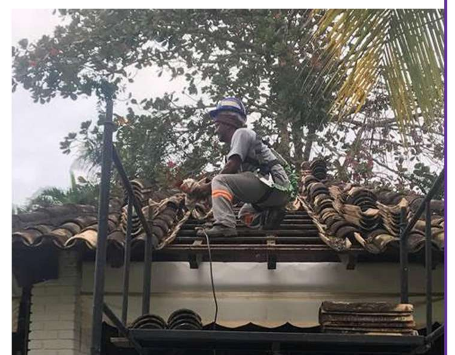
Reforma do telhado Osmar Santos
