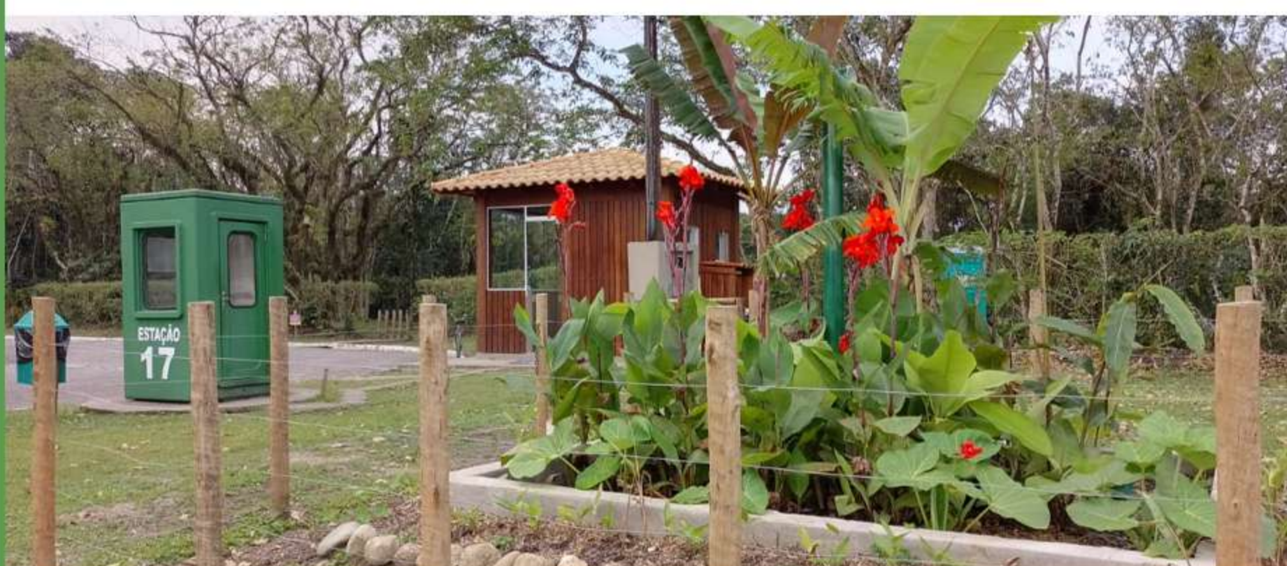
Base de apoio comunitária com sistema de saneamento ecológico
